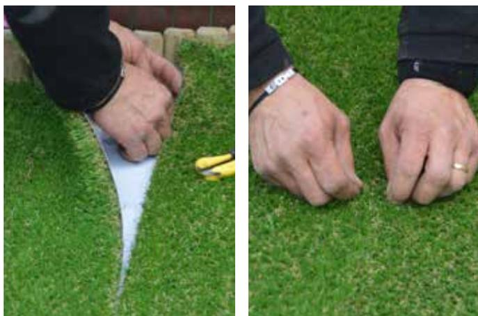
Controllare l'unione dei due lembi di prato, facendo pressione con le mani per farla aderire bene al nastro monoadesivo; fare attenzione che l'unione sia completamente invisibile e risulti senza tensioni o rigonfiamenti.
