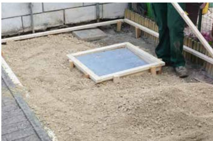
Se il pozzetto è più basso della quota dell'area di posa, aver cura di portarlo alla stessa quota del pavimento esterno, (come detto all'inizio -2 cm).
