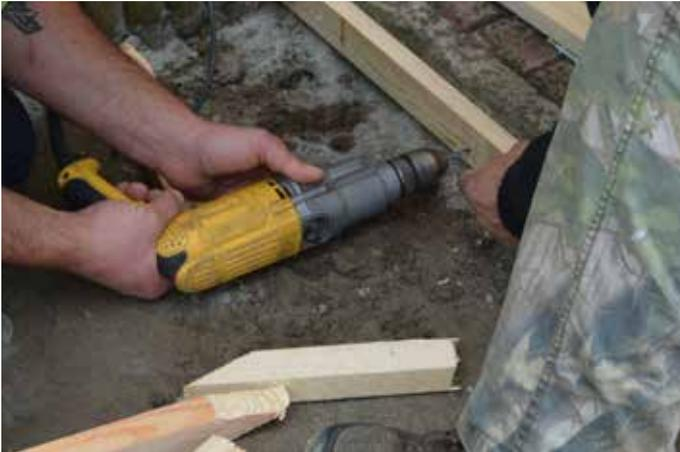
Nel caso capitasse di non riuscire a piantare dei picchetti, a causa di ostacoli nel sottosuolo, si possono fissarle direttamente al cordolo della pavimentazione usando dei tasselli per viti a pressione.
