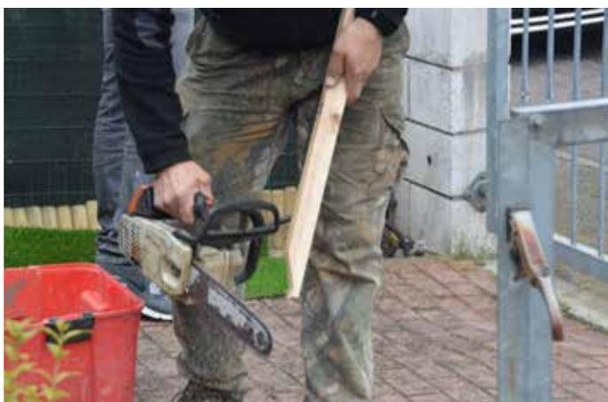
Con l'ausilio di una sega a motore oppure con seghetto da legno manuale, tagliare a misura gli stanghetti di legno di dimensioni 4x2,5 cm di sezione, di pino oppure di abete per creare il perimetro dell'area da realizzare.
