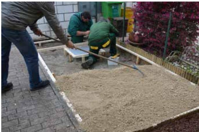
Una volta ultimato il perimetro, si procederà al riempimento dell'area con dello stabilizzato Ø 8-10 mm e la successiva stesura uniforme, facendo attenzione a riempire tutti gli spazi anche sotto al perimetro in legno.
