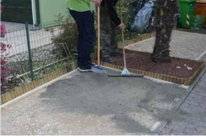
Sopra allo stabilizzato compattato stendere uno strato sottile e uniforme di sabbia silicea  $\varnothing$  0,6-1,2 mm.
