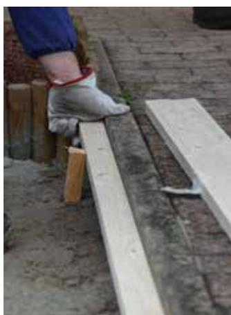
Disporre gli stanghetti lungo il perimetro dell'area di posa, avendo cura di posizionarli ad una quota inferiore di 2 cm da quella della pavimentazione esistente. (sempre in base al tipo di prato scelto)
