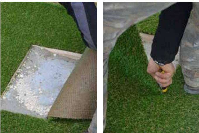
Tagliare la parte di prato che ricopre il pozzetto con precisione, ed incollarla con del nastro biadesivo al coperchio del pozzetto.
